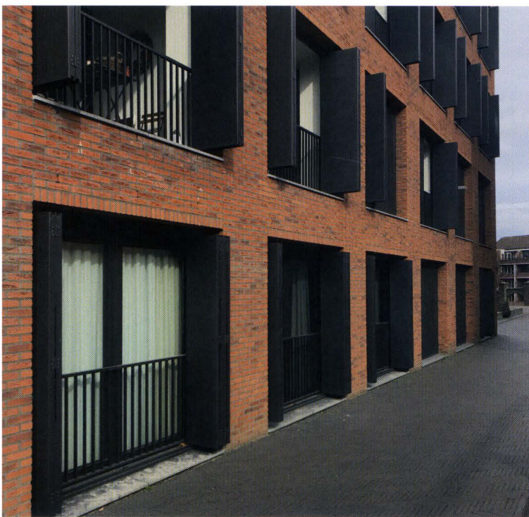
Diep uitgesneden raamopeningen met handmatig te bedienen vouwluiken
